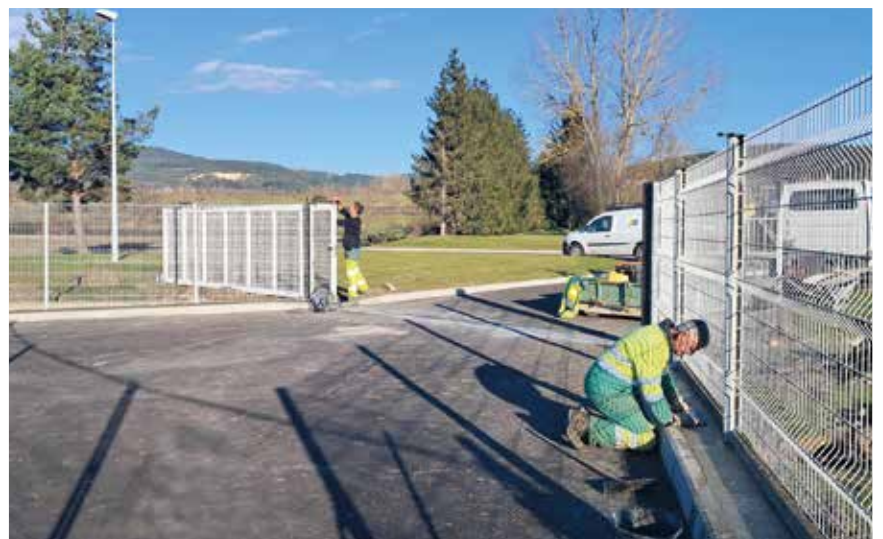
COMPLEXE DE LA PLAINE : DÉPLACEMENT DU PORTAIL VERS LA NOUVELLE ENTRÉE
