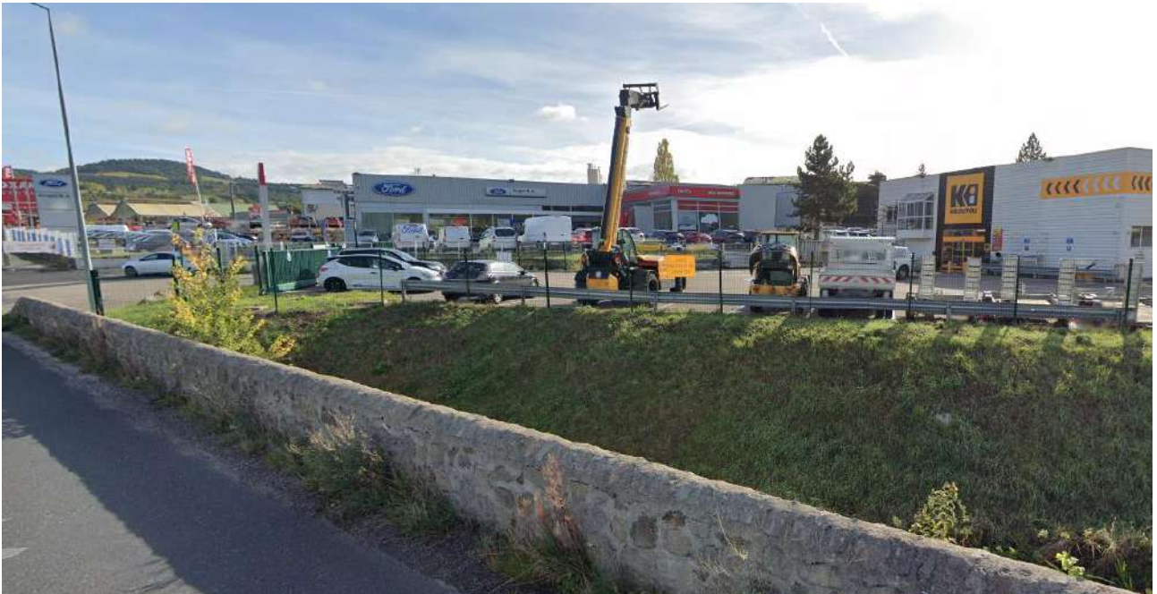
Vues frontales sur la ZA depuis le site en direction du Sud-Est
